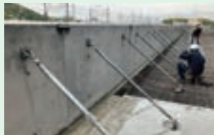
PC腰壁 施工写真 (千葉県市川市)
