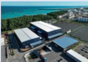
施工事例 (静岡県焼津市)
