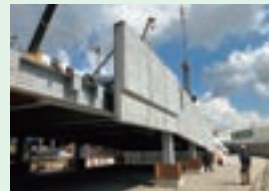
PC腰壁 施工写真 (兵庫県川西市)
