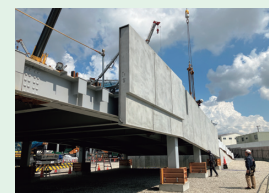
PC腰壁 施工写真 (兵庫県川西市)
