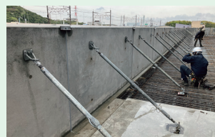
PC腰壁 施工写真 (千葉県市川市)
