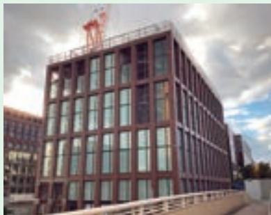
施工事例（兵庫県西宮市）①
