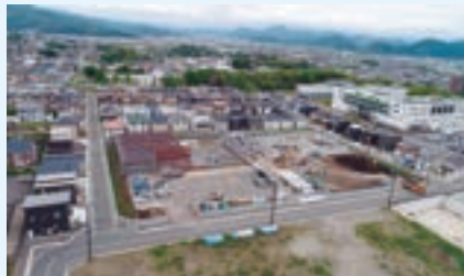
開発中（静岡県田方郡函南町）
