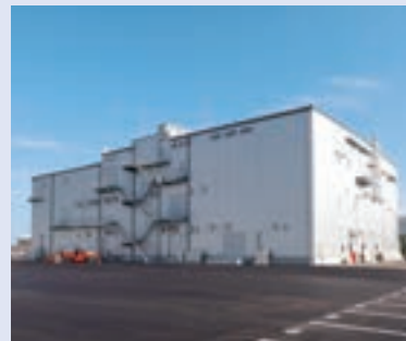
施工事例・食品メーカー工場（静岡県焼津市）
