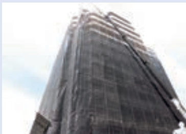
エンブル・ステーション清水管理組合様 大規模修繕（静岡県静岡市清水区）
