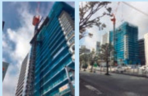
ザ・エンブル七間町 建設中（静岡県静岡市葵区）
