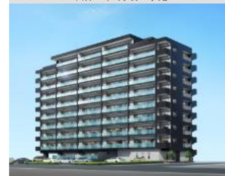
エンブルステーション菊川(全45戸) 平成29年3月竣工予定
