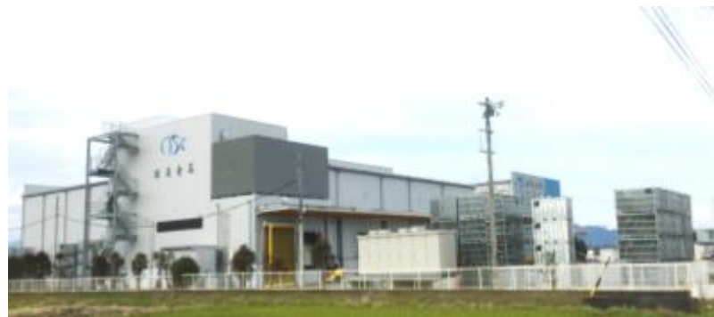
工場施設誘致プロジェクト (焼津市) 4,958坪
