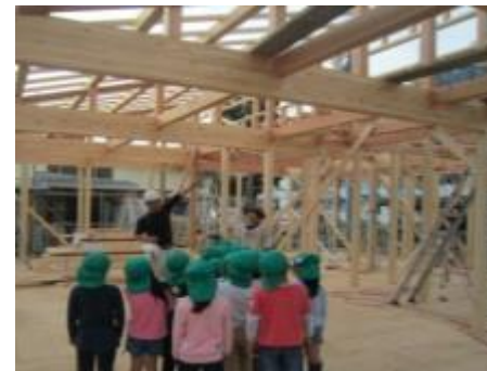
某保育園施設 (静岡市葵区)
