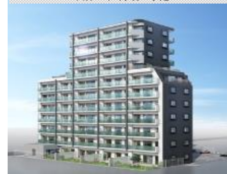
エンブルエバー掛川城西(全42戸) 平成29年3月竣工予定
