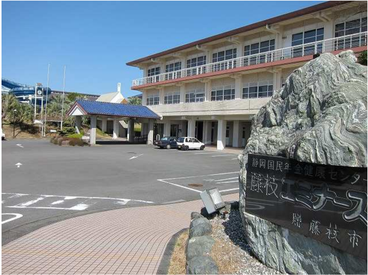
▲旧 藤枝エミナース (玄関より本館・プールを見る)
